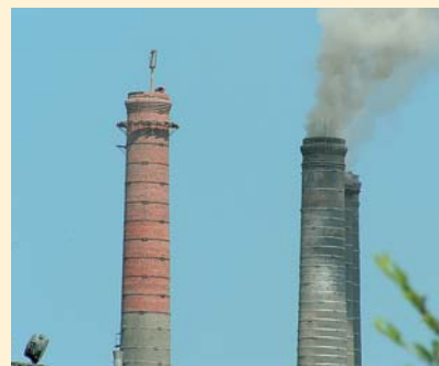
Перекладка кирпича дымовой трубы в городе Михайловка
