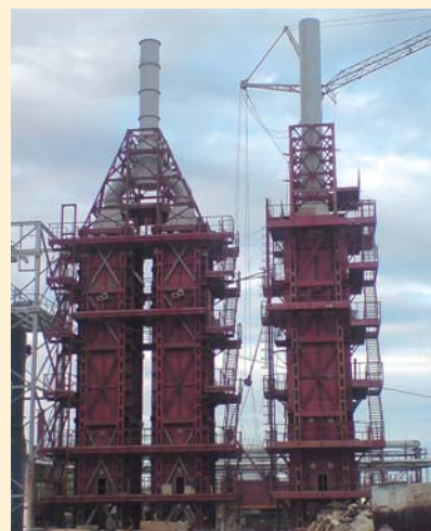
Монтаж металлоконструкций на Астраханском газоперерабатывающем заводе
