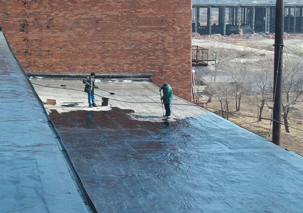
Гидроизоляция крыш (видео на сайте www.meravod.ru )
