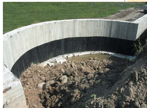
Гидроизоляция фундамента
